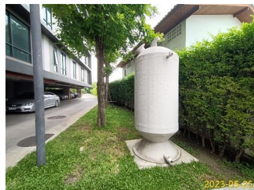
ระบบกำจัด Aerosol/ระบบกำจัดมีเทน
