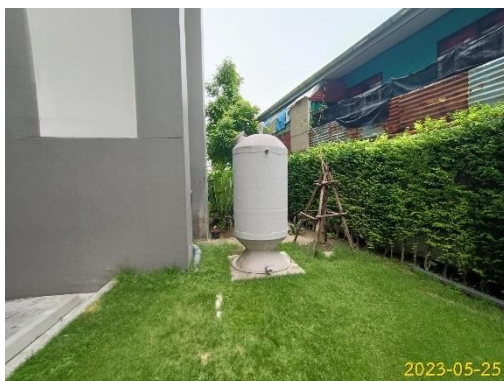
ระบบกำจัด Aerosol/ระบบกำจัดมีเทน
